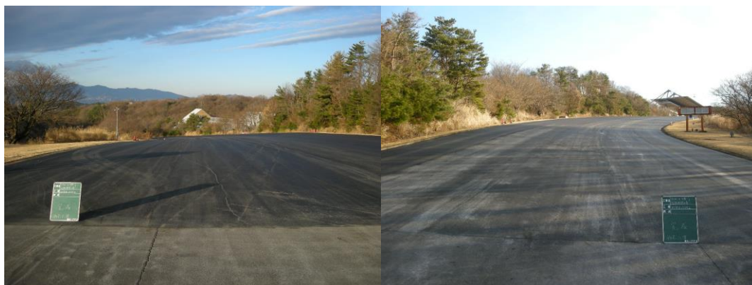
5キロサーキット 第1下り 走路補修 完成
